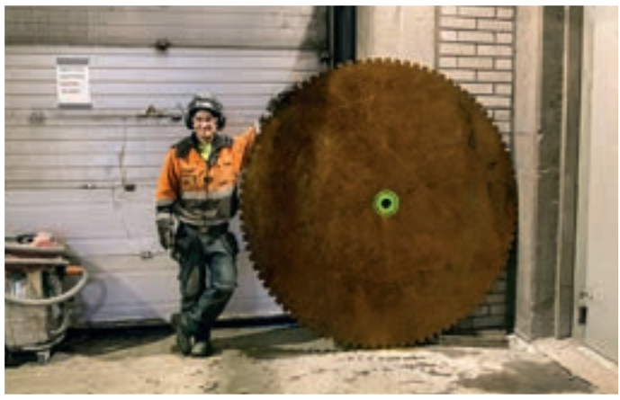
■ LAIKKA KAINALOSSA. Tämä on Suomen suurin timanttilaikka ja se on tärkeässä roolissa tällä työmaalla. Kaivukoneita löytyy joka lähkseen sopivasta kokoluokasta.
